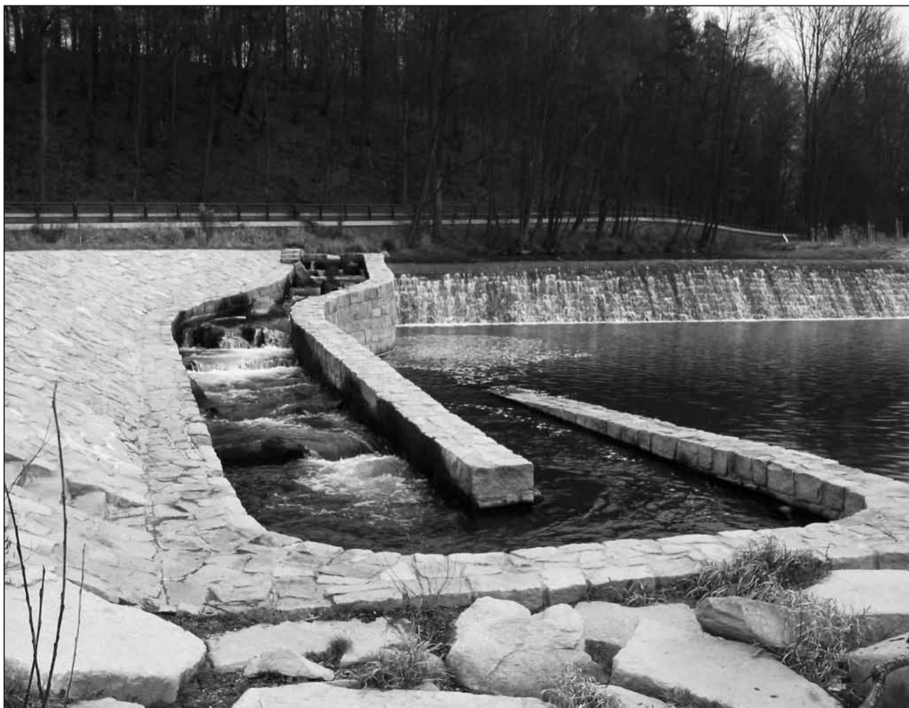
Rybí přechod na jezu v Bernarticích nad Odrou je osídlen rybami a rakem říčním. V důsledku nevhodného uspořádání vnitřní struktury migračního prostoru dodavatelem stavby neplní svou funkci a neumožňuje rybám proplutí z dolní vody do nadsjezí (Foto Bohumír Lojkásek).
